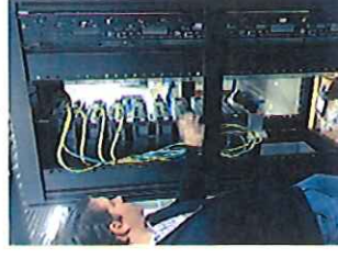
Les tableaux électriques en cours d'assemblage (Photo. L. Framery)
