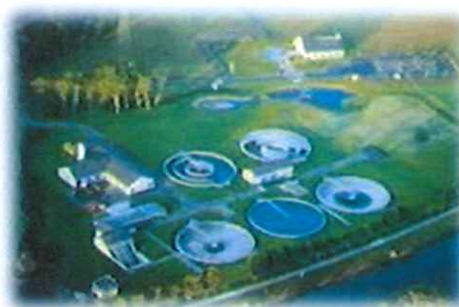
Station d'épuration d'Ipalle Froyennes
