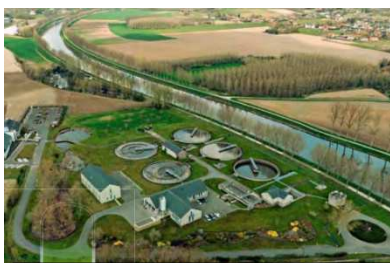
Photo issue du site Ipalle.be
