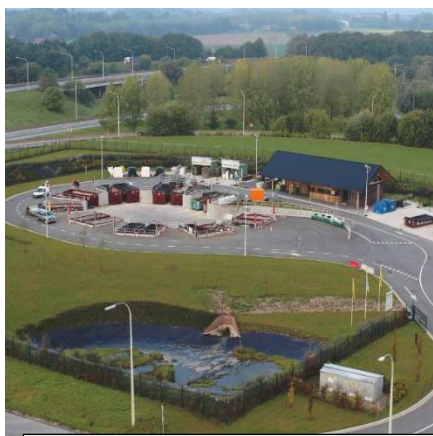
Photo issue du site Ipalle.be
